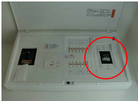
一体型分電盤例
